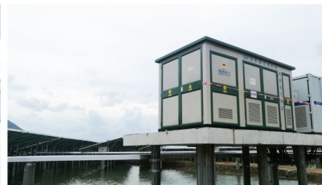
台山渔业光伏项目
