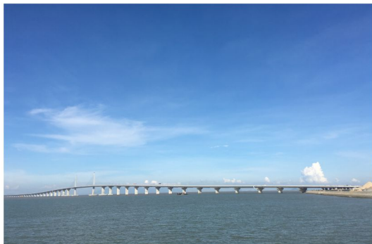
珠海港珠澳大桥项目
