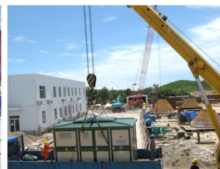
广西防城港核电项目
